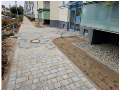
erneuerte Gehwege in der Dünenstraße
